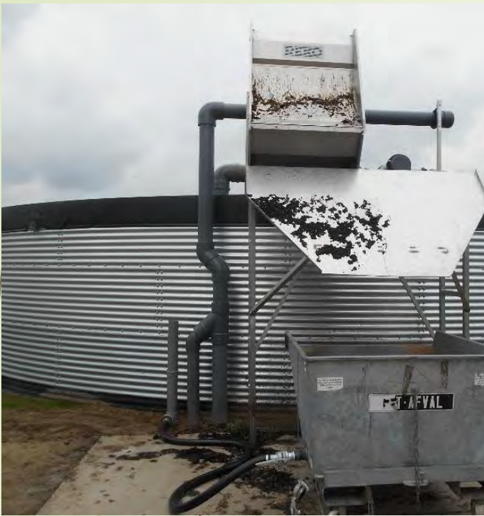
Zeefbocht als voorfiltratie op extra buffer (= enkel voorfiltratie)
